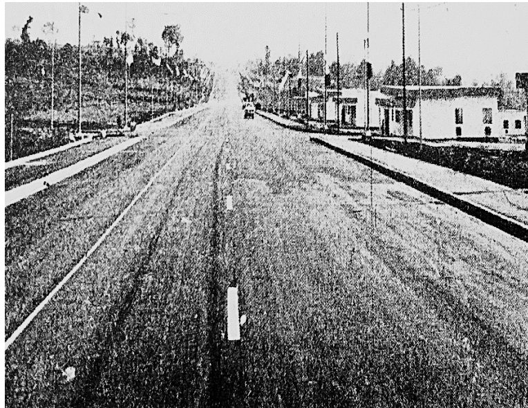
Photo N°1: La nouvelle voirie de Katiola
